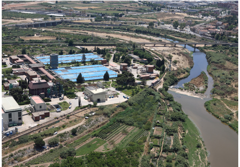
Aigües de Barcelona Sant Joan Despí Drinking Water Treatment Plant
